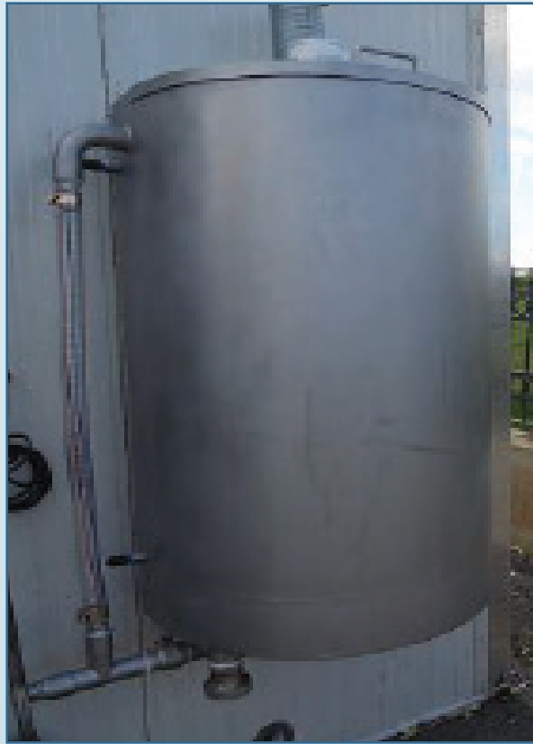
◆ خزان تجميع المياه النظيفة
