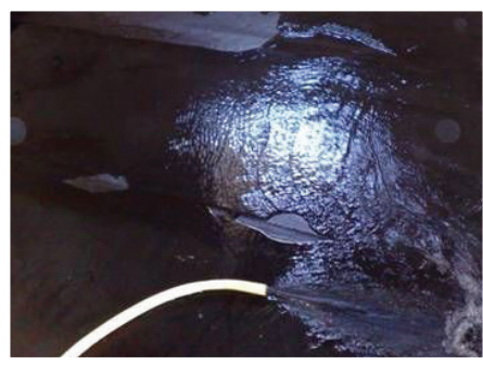
شكل (2) : يوضح تعبئة الماء على عازل الرطوبة لاختباره ويشاهد ارتفاع العازل على الجدران
