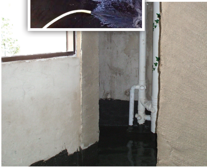
شكل (2) : يوضح تعبئة الماء على عازل الرطوبة لاختباره ويشاهد ارتفاع العازل على الجدران
