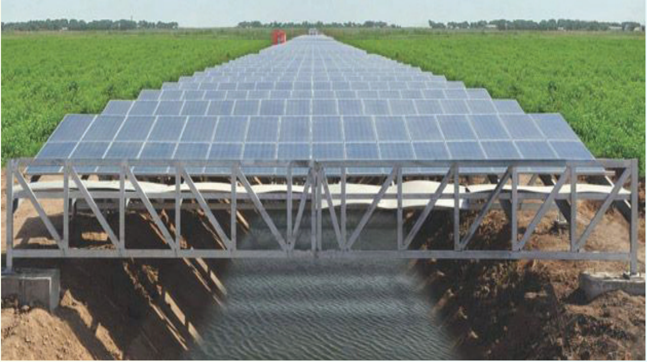
الصورة توضح فكرة مبتكرة تم تنفيذها في أحد المشاريع حيث تم وضع الألواح فوق قناة تخزين المياه لتحقيق هدفين :
