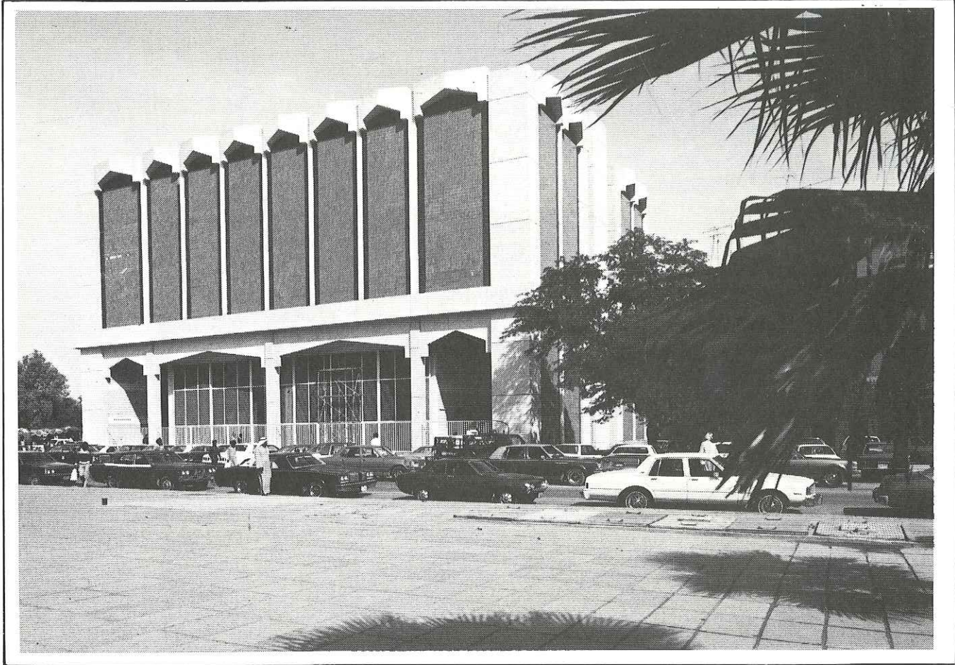
مبنى محطة ضغط عالي
