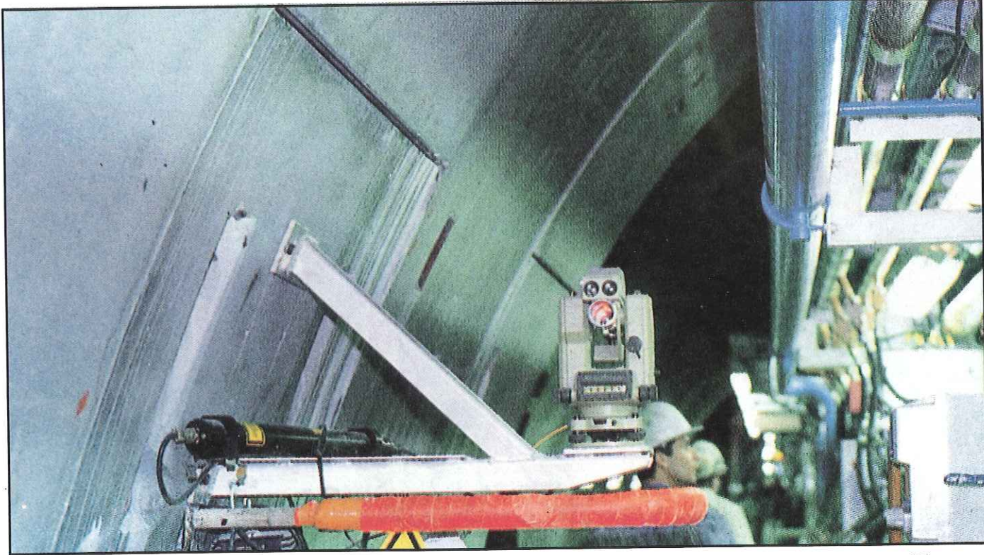
شكل (3) تم تثبيت مساند مسح ثابتة في جدران النفق على مسافة كل 45 مترا وتوضح الصورة جهاز تم نصبه لتعيين خط الوسط والسيطرة على أعمال المسح .
