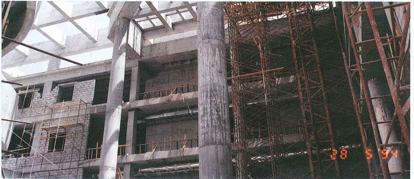
جسور وأعمدة المبنى الرئيسي في الخالدية قبل إكسائها
