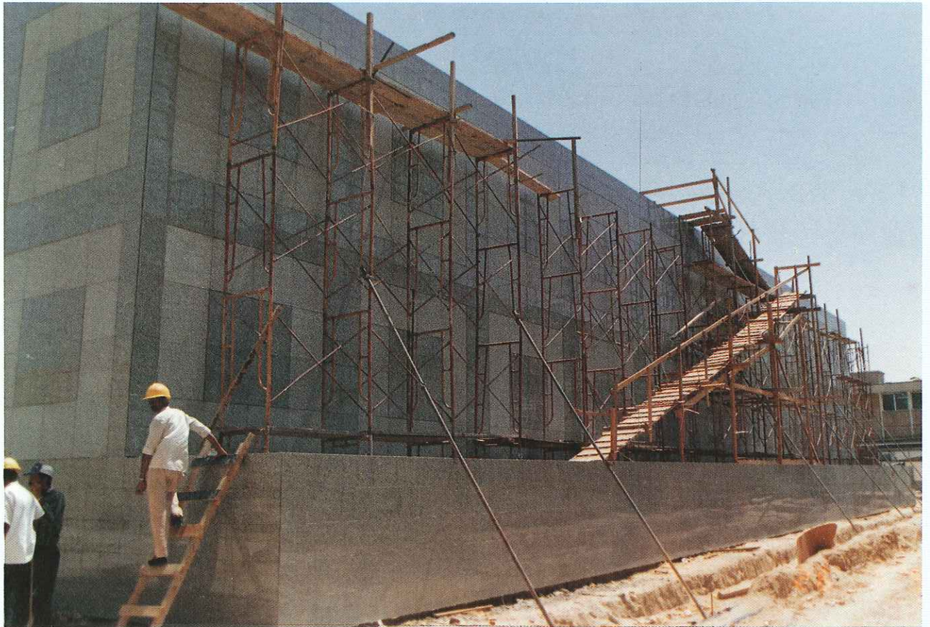
عملية إكساء الجدار الخارجي لأحد مباني المشروع
