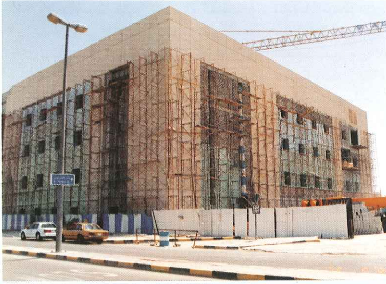
أثناء بناء الجهة الغربية لمبنى المكتبة في الخالدية
