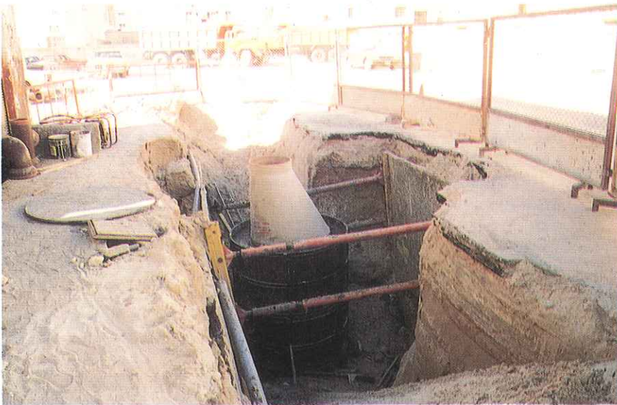
■ عملية بناء المنهول ■
