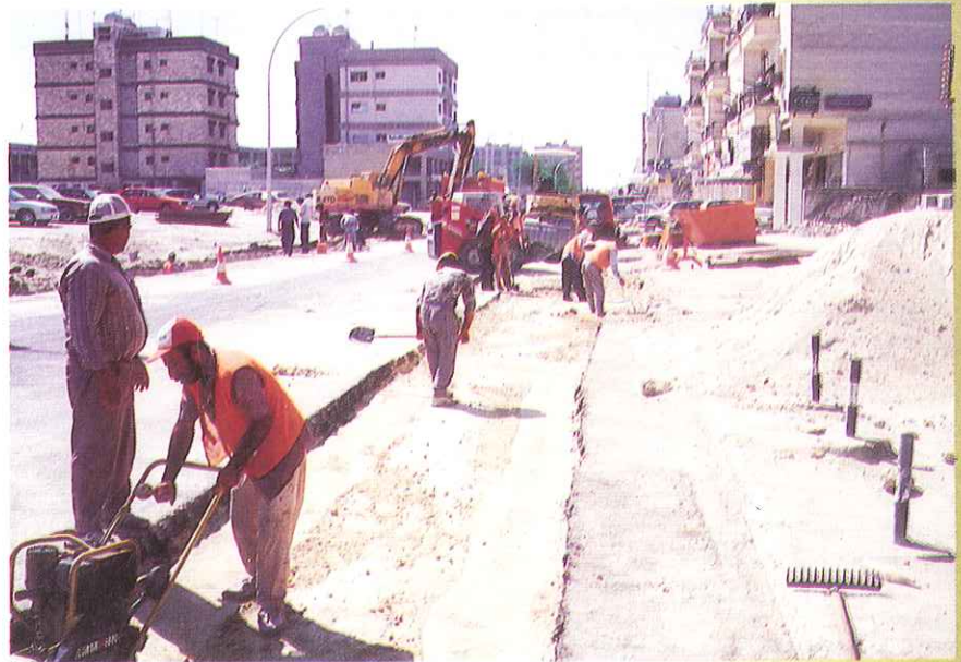
■ عملية الردم بعد الانتهاء من التحديث في أحد المواقع.
