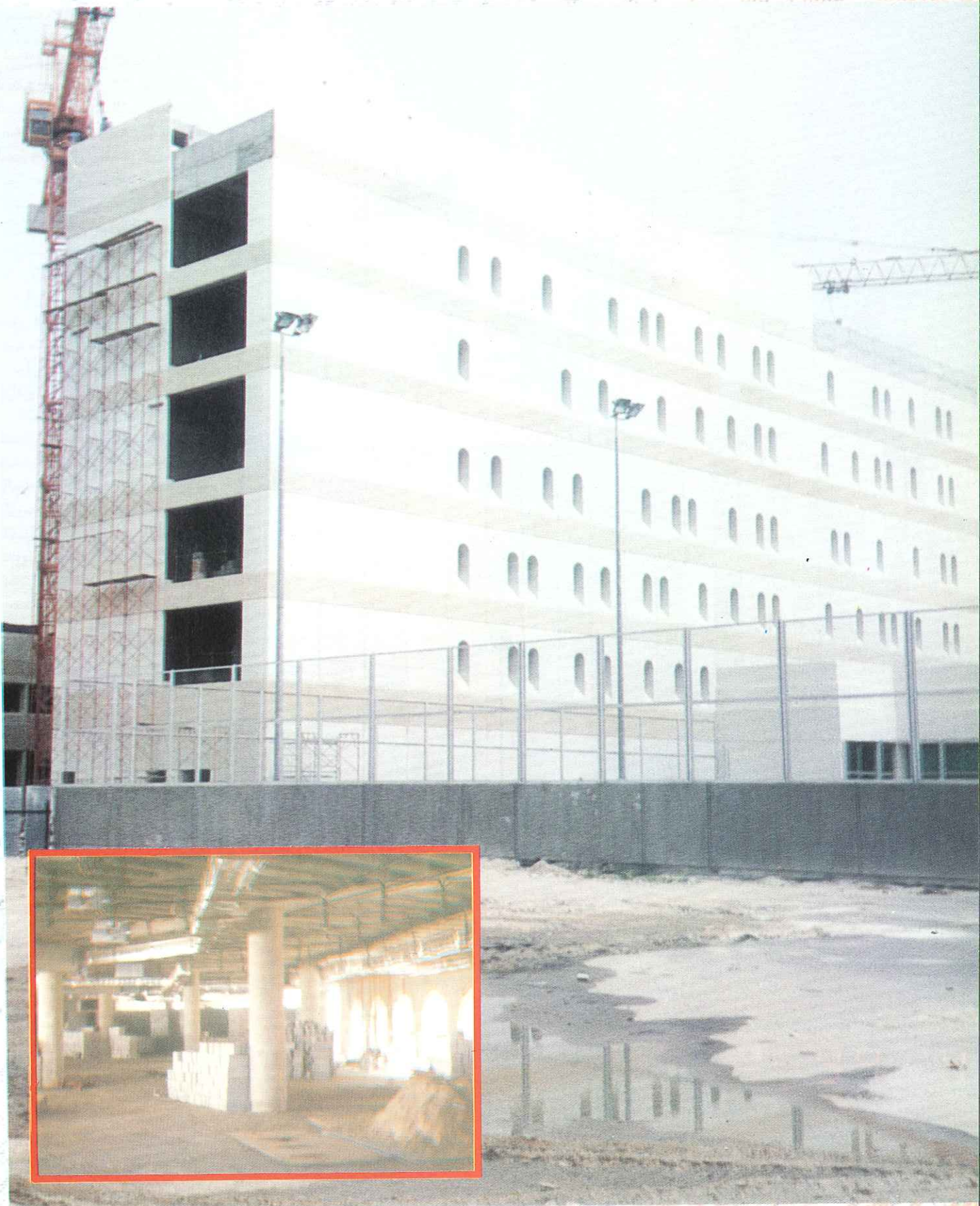
● واجهة المبنى الجانبية وهي الإطار تشييد الدور الأرضي من المبنى ●
