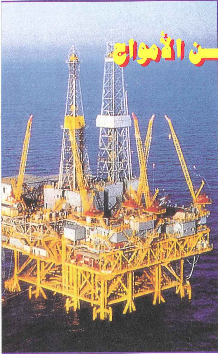
منصة بول وينكل التي بنتها شركة شل أعلى من برج سيزن لكن معظمها في باطن الأرض
