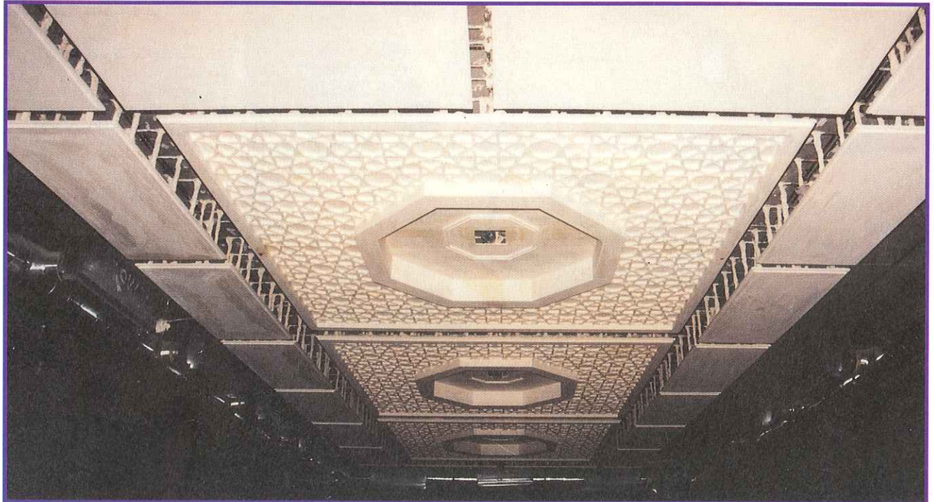
■ الشكل المبدي لسقف إحدى الصالات ■
