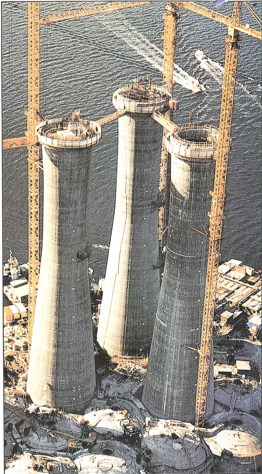
استخدام طريقة الشدة المنزلقة في إنشاء المنصات البحرية للبحث عن البترول
