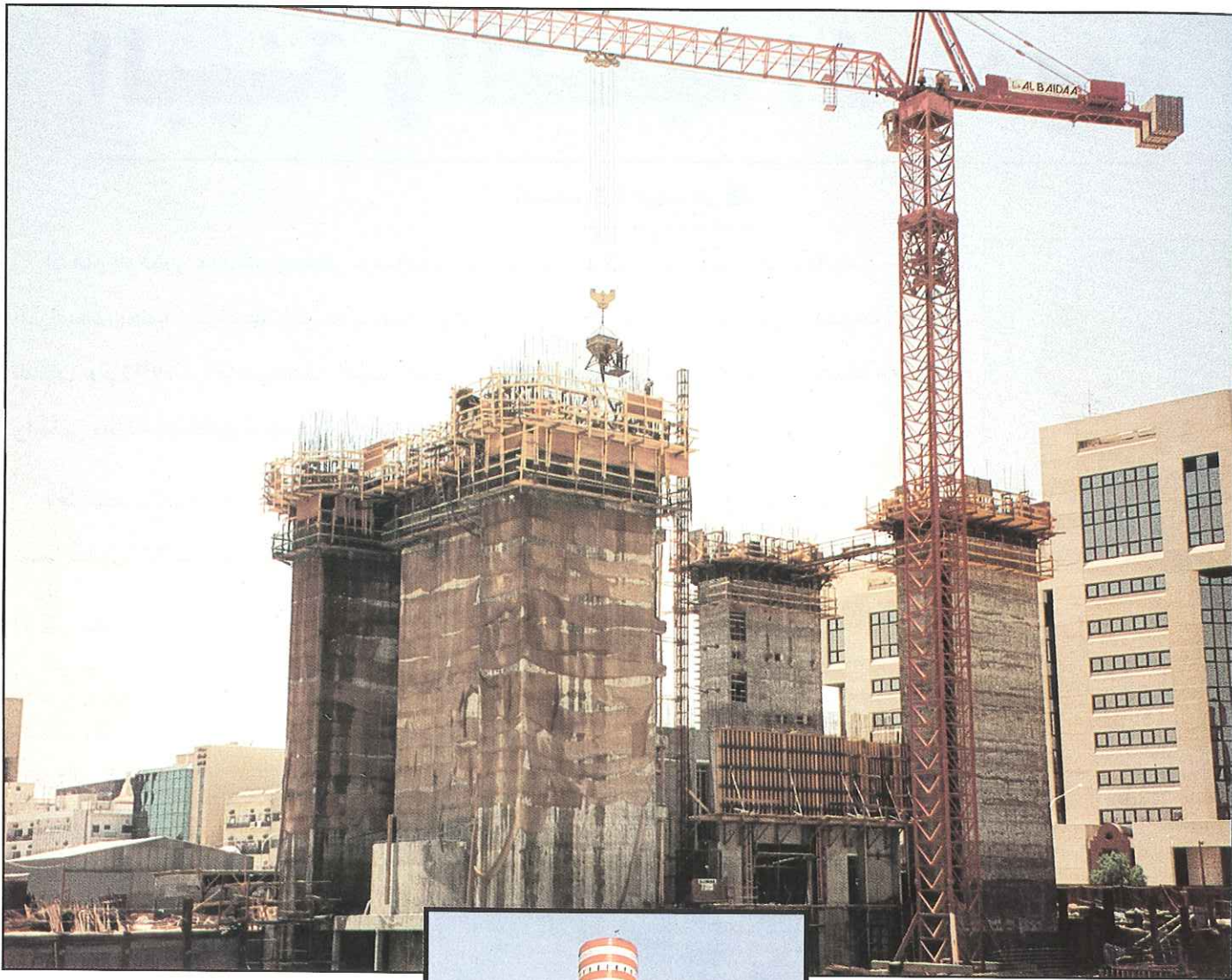
استخدام طريقة الشدة المنزلقة لتنفيذ إحدى المنشآت الهندسية المنتظمة الأبعاد
