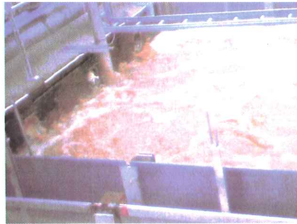
(شكل 5) حوض تهوية أثناء العمل والكتل البلاستيكية ضمنه
