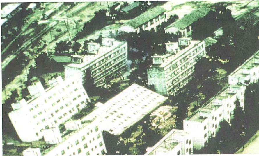
■ زلزال نيجانا اليابان 16 يونيو 1964، قوته 7,4 درجة، تظهر الصورة هبوط أرض عند أساسات المباني نتيجة لتميع التربة ■
