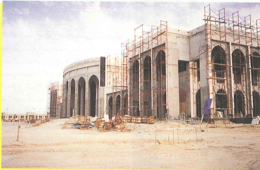
■ تشييد إحدى الواجهات
