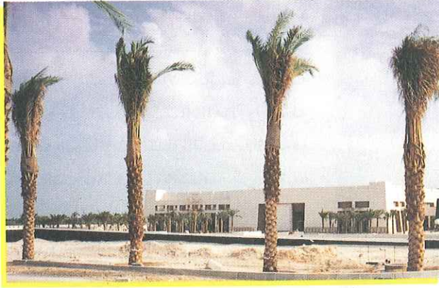
■ زراعة النخيل تواكب عملية البناء
