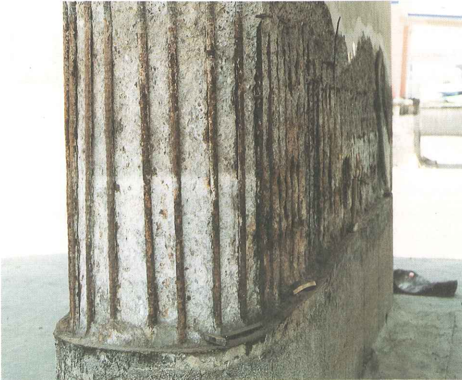
(شكل - 1) التلطف في الخرسانة وتآكل الحديد
