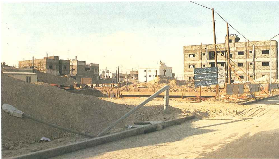
وجود ردم في موقع العمل بكميات كبيرة يعيق الحركة، وتبين الصورة إتلاف المرافق العامة
