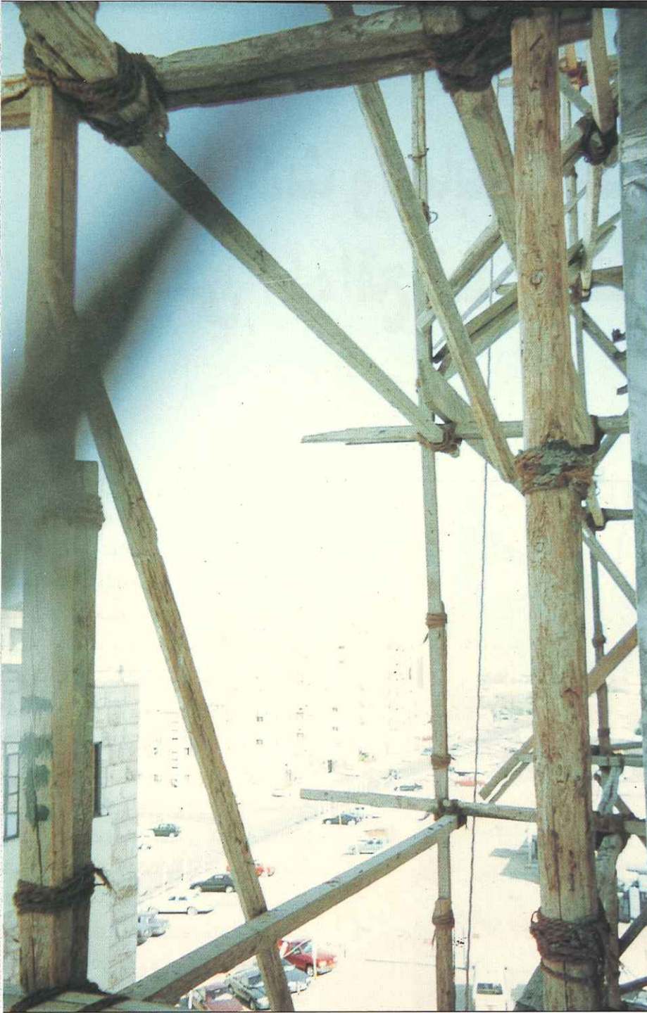
استعمال أخشاب مهترئة وتصميم ضعيف للسقالة أدى إلى سقوط عامل منها
