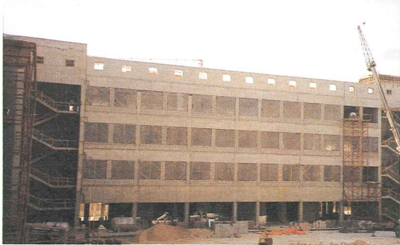
المبنى F قيد الإنشاء
