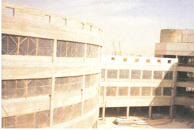
المبنى H قيد الإنشاء
