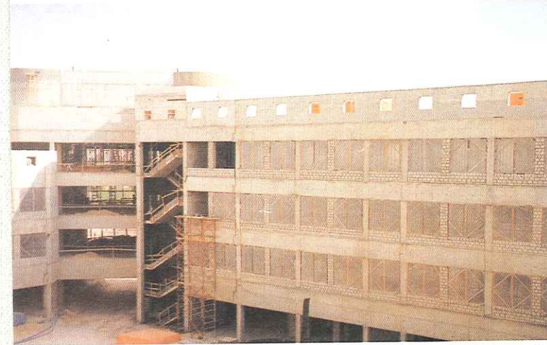
المبنى G قيد الإنشاء
