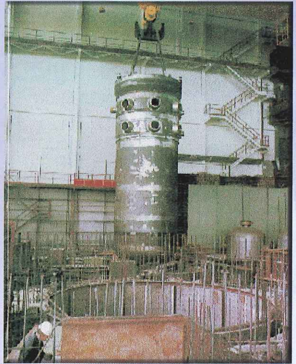
(الشكل 3). منظر لقلب المفاعل قبل ادخاله داخل الوعاء
