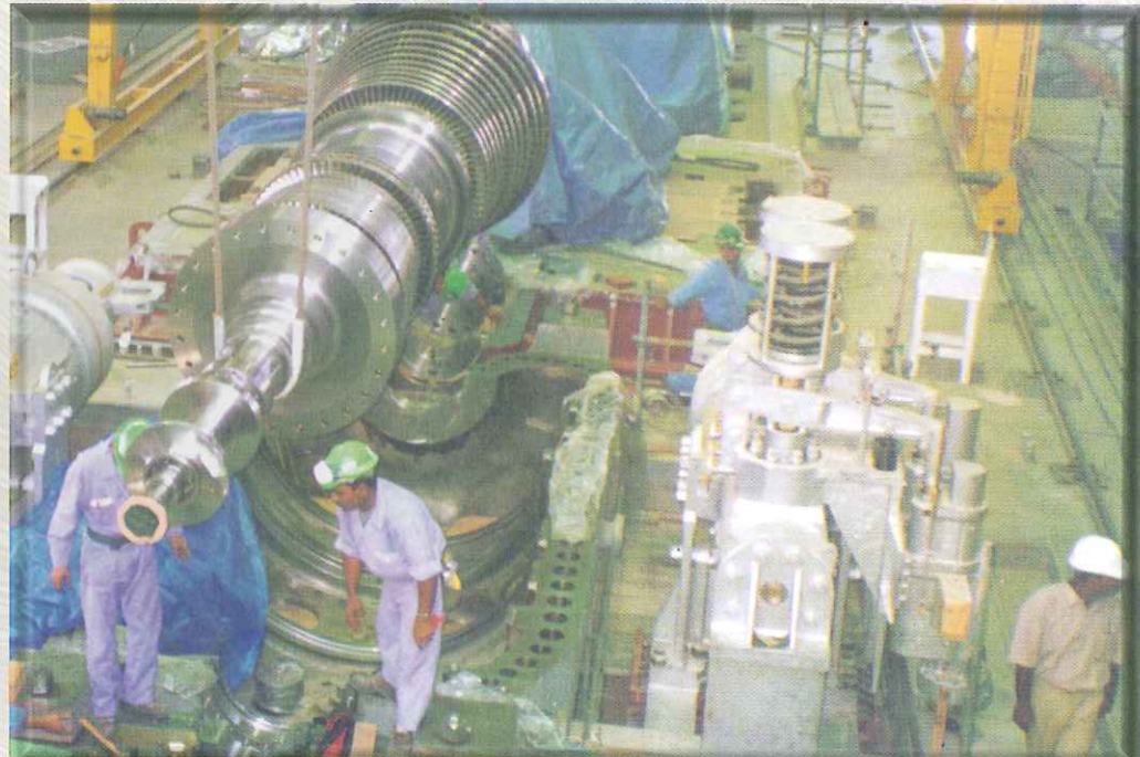
محاولة تثبيت عمود الدوران المشترك لمرحلي التوربينية البخارية ذات الضغط المرتفع وذات الضغط المتوسط
