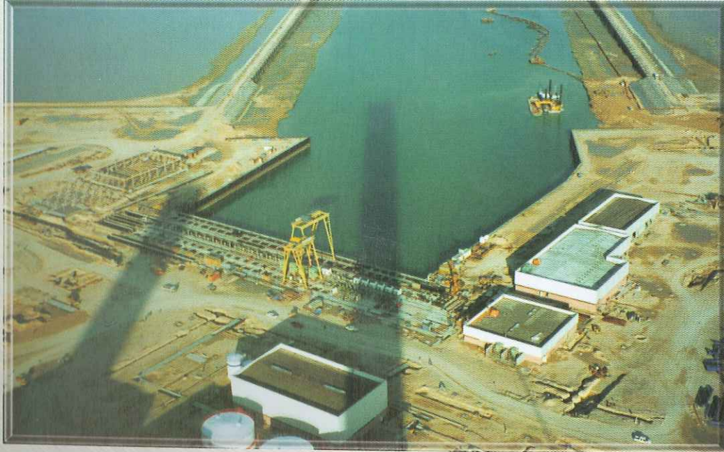
متأخذ مياه البحر للمحطة وتبدو بعض خزانات المياه
