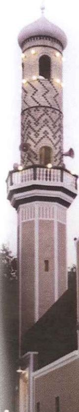
مسجد براك الدماك بعد ترميمه من الخارج
