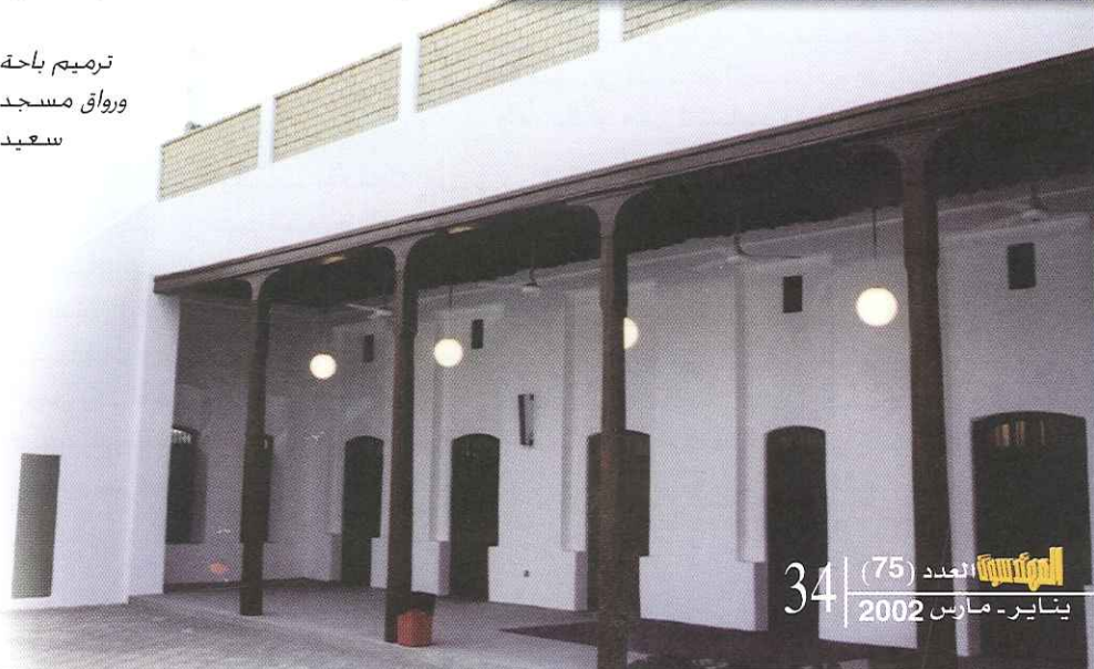
ترميم الحوائط والأبواب في مسجد العتيقي
