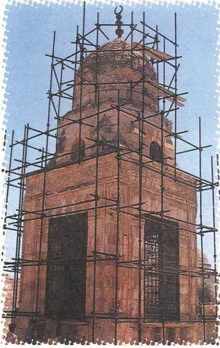
سبيل قايتباي أثناء ترميمه
