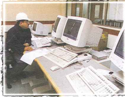
غرفة تحكم حديثة
