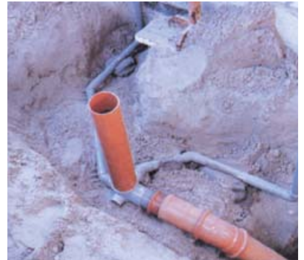
وضع أنابيب الصرف الصحي
