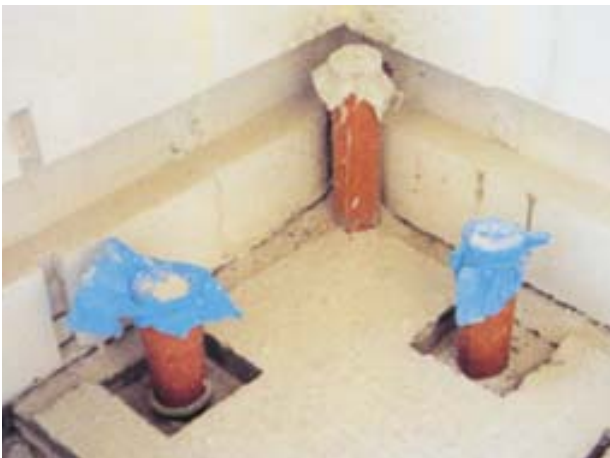
تركيب أنابيب الصرف الصحي
