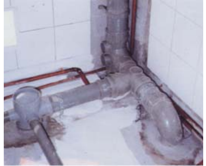
تركيب تمديدات الأعمال الصحية والتزويد بالمياه الباردة والساخنة
