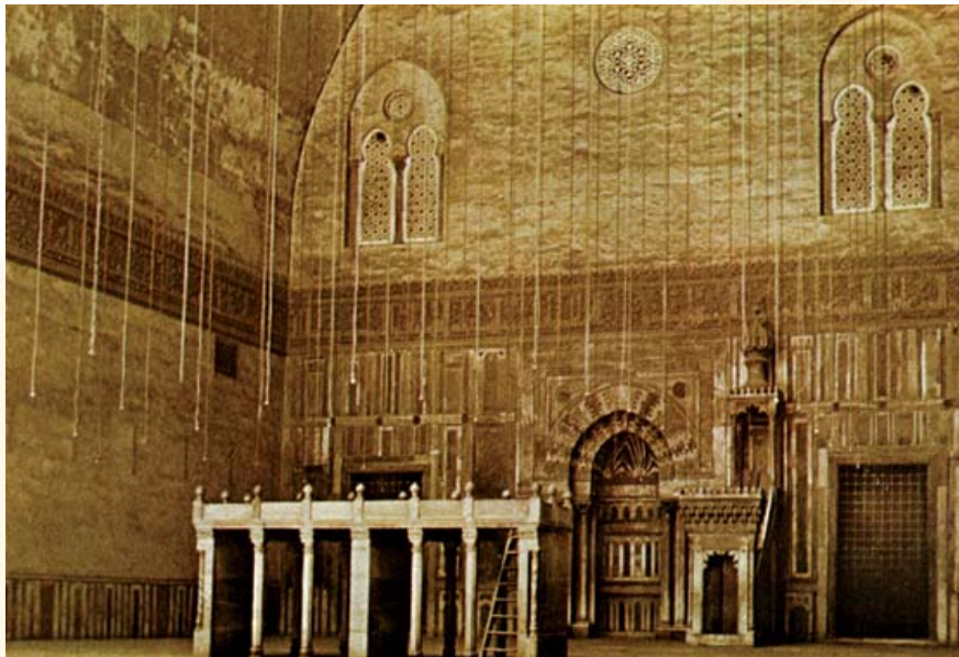
قام المهندس بكسوة جدار القبلة بالرخام بكامل الارتفاع حتى اسفل الكتابة بعكس الجدران الجانبية التي تحمل القبة حتى لا تضعف الزخرفة الاحساس بالقوة الإنشائية
