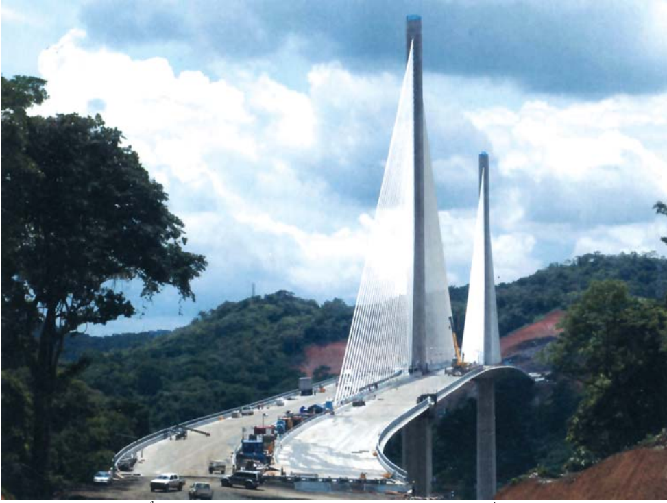
تم ترتيب 28 كيبلاً بشكل تباعدي كل 6م وذلك بنموذج شل مروحة وقد صُفّت إلى أرضية الجسر بواسطة عارضة
